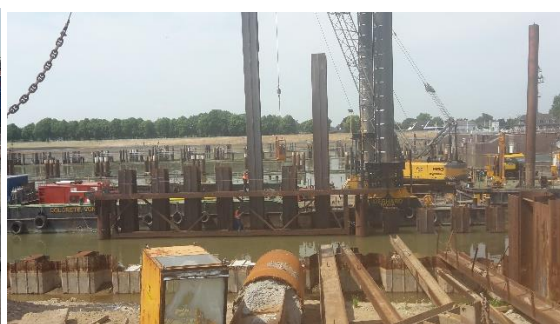
Gründungsarbeiten vom Wasser aus
