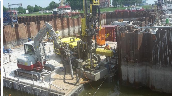
Die Arbeiter tragen Rettungswesten
