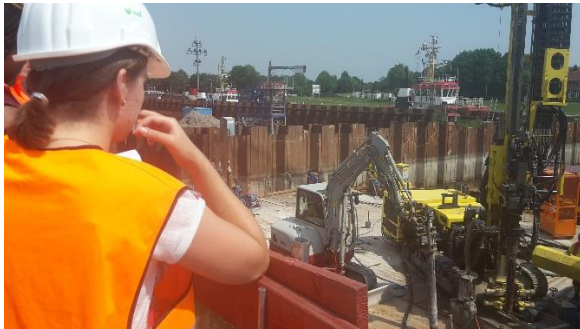
Tiefenbohrung im Wasser
